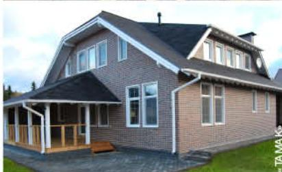
В панельно-каркасных домах «ТАМАК» серии «Готовый дом» все стены, перекрытия и перегородки состоят из модульных элементов — панелей заводской готовности. На стройплощадке остается лишь собрать их в единую систему по типу конструктора.
