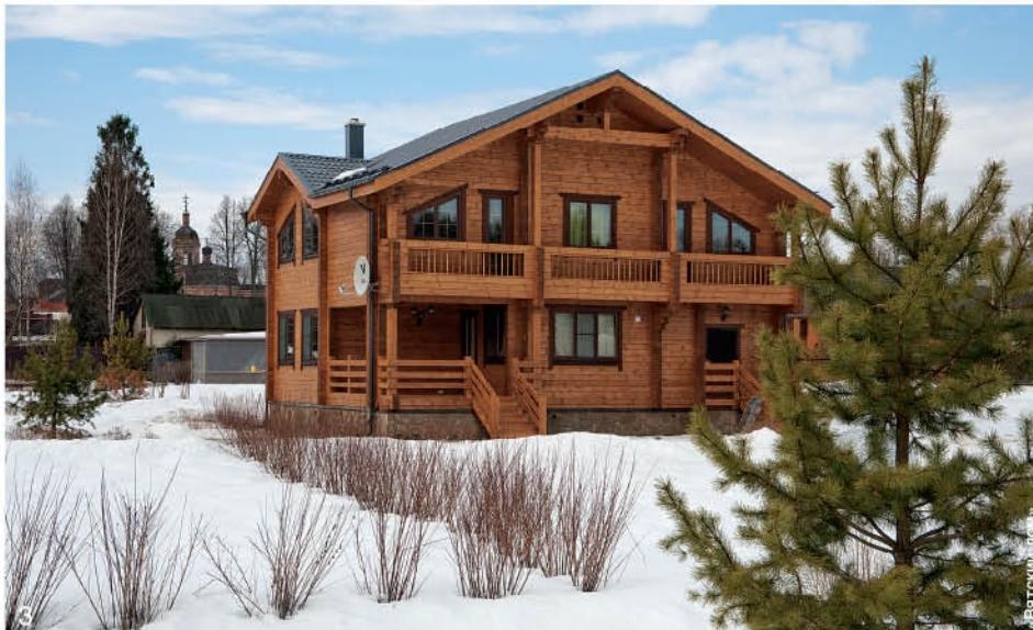
1, 5. Стеновой профилированный kleеный брус «ТАМАК» с Ш-образным профилем не требует укладки утеплителя вдоль бруса. Утепляются только замковые соединения
