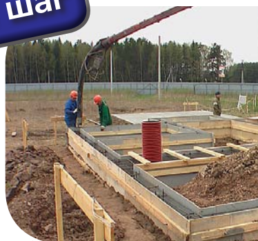
Заливка ленты бетоном
