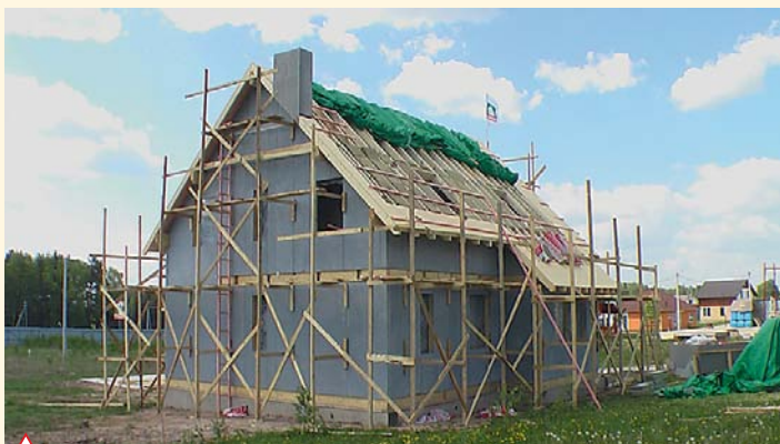
Укладка утеплителя в конструкцию крыши
