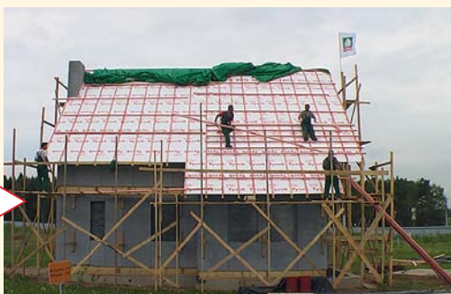
Укладка гидроизоляции и крепление обрешетки
