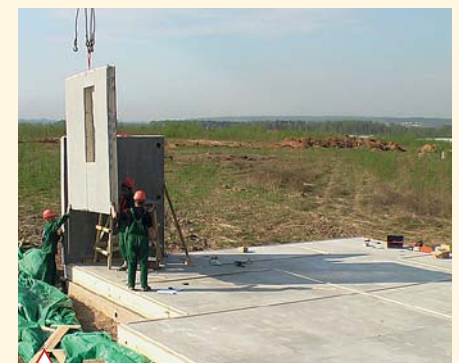
Начало установки стеновых панелей
