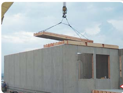
Установка плит перекрытия
