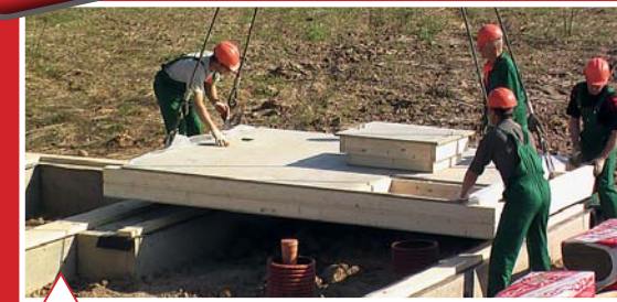
Цокольные перекрытия – готовые конструкции пола первого этажа
