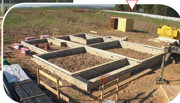
Уложен опорный брус
